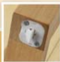
Le loquet se réactive lorsque le volet est en position fermée
