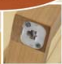
Loquet rétractable pour la bascule du volet
